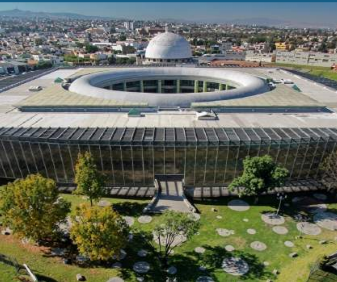
EDIFICACIÓN: Centro Educativo y Cultural del Estado de Querétaro "Manuel Gómez Morin", Mpio. de Querétaro, Qro.
