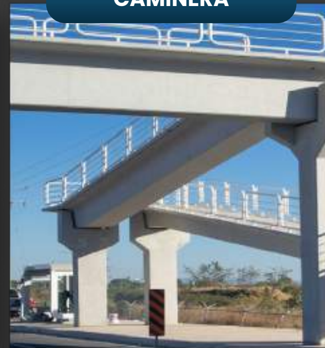
Construcción de Puente Peatonal en el kilómetro 32+740, Carretera Estatal 100. Ezequiel Montes, Qro.
