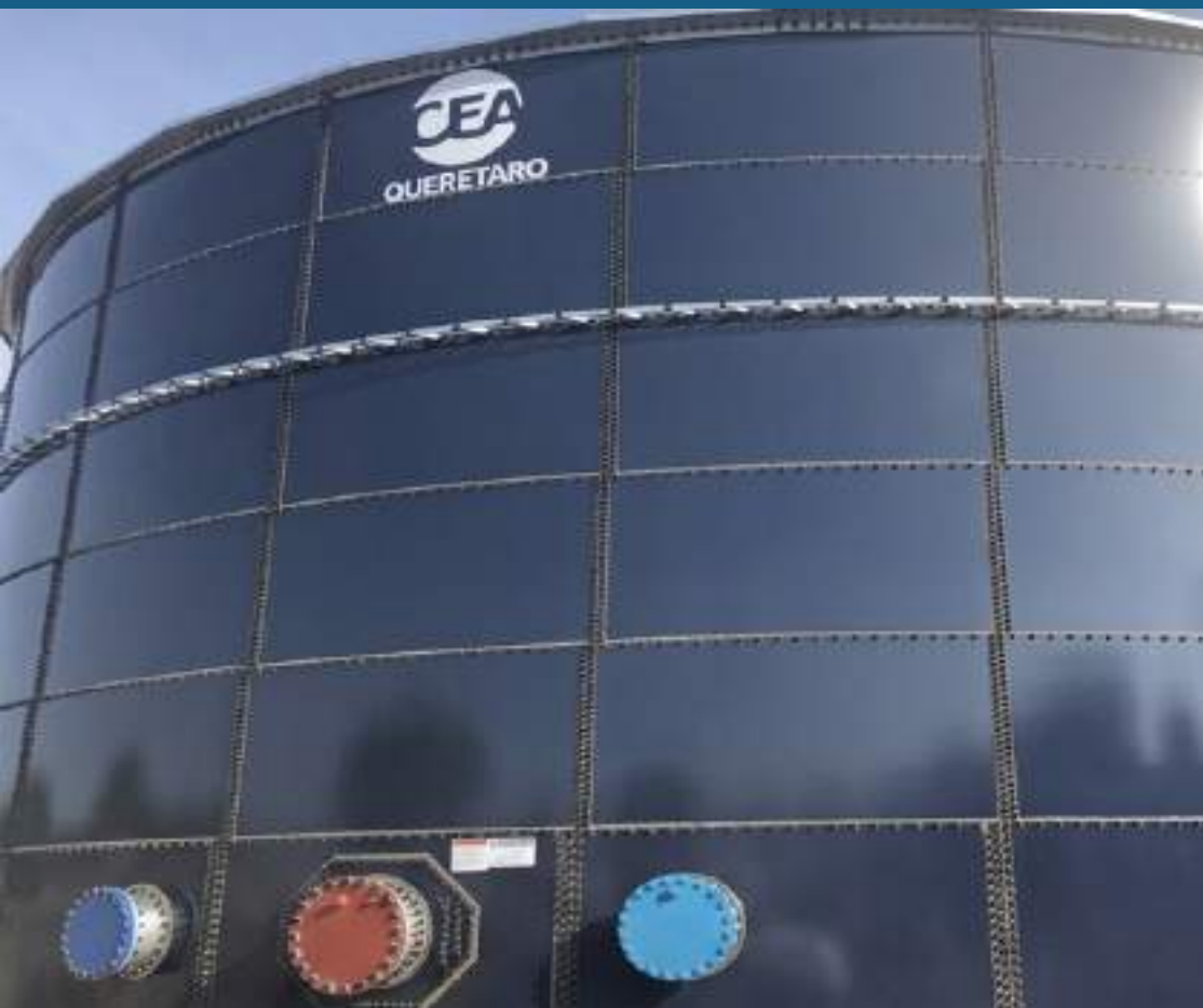
HIDRÁULICA: Tanque de Almacenamiento para Agua Potable, Comunidad San Francisco - Arroyo Hondo, Mpio. de Corregidora, Qro.
