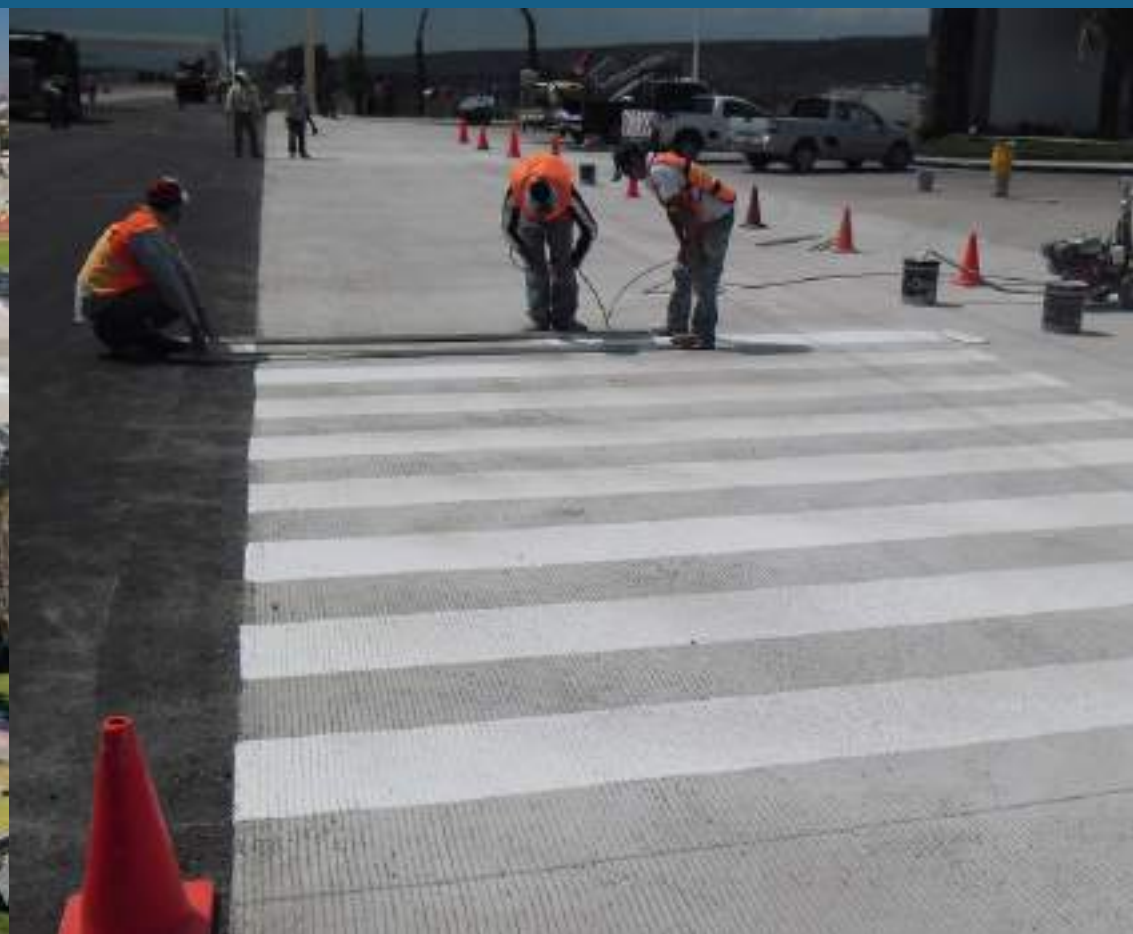
CAMINERA: Carril de Desaceleración para Acceso al Parque Industrial AeroTech, Carretera Estatal No. 200, Mpio. de Colón, Querétaro.
